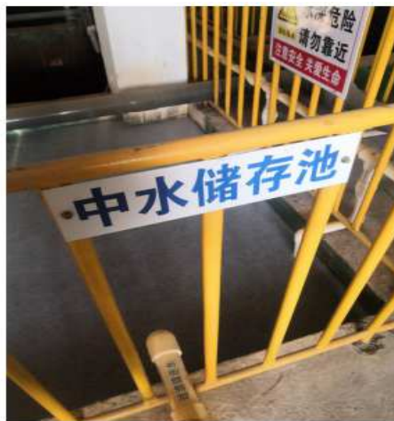
污水处理站中水储存池
